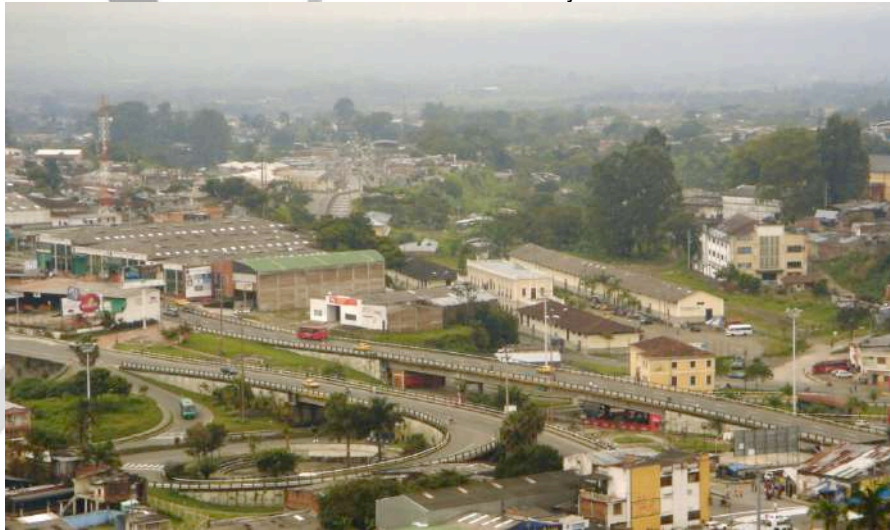
Ilustración 21. Intercambiador vial de La Cejita
