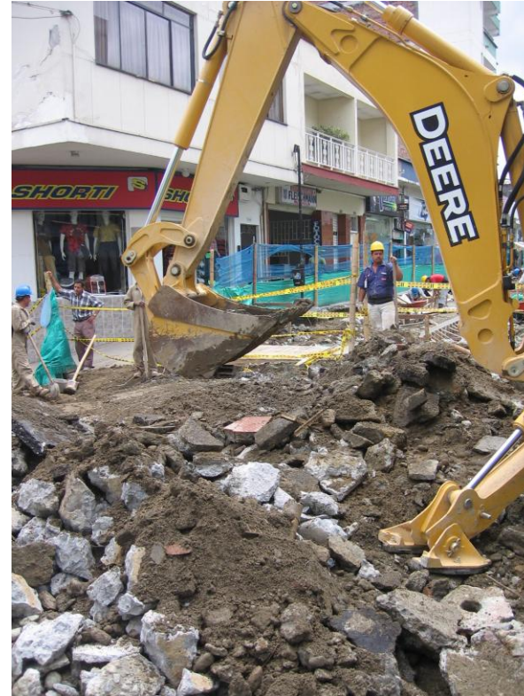
Construcción Centro Comercial de Cielos Abiertos 2007
